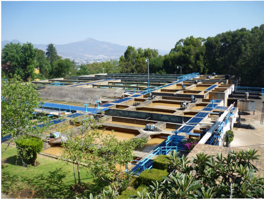
Fotografía 1. Panorámica de la planta potabilizadora situada en la Colonia Vista Bella. Mayo 2012
