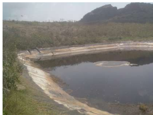
(b) Laguna de lixiviados Sureste
