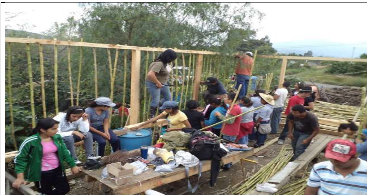
Figura 23: Faena para la construcción de la Casita comunal
