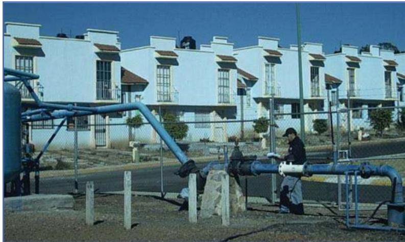
Pozo profundo con bomba sumergible para suministro del fraccionamiento Villa Magna
