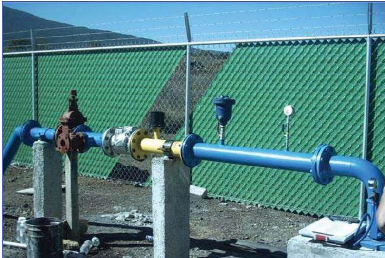
Pozo profundo, bomba sumergible que abastece al fraccionamiento operando 12 hrs/día
