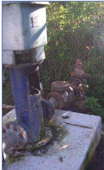
Pozo profundo con sumergible y bomba vertical en serie
