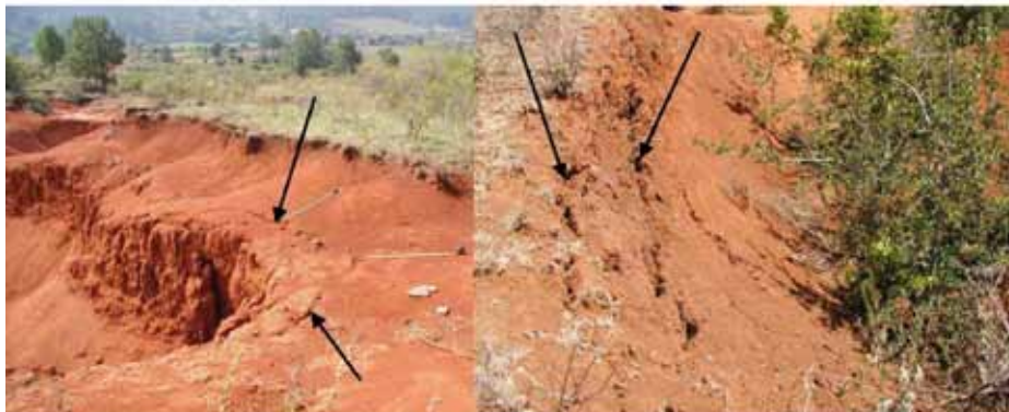
Figura 5. Agrietamiento de cabecera y taludes (se indican con flechas).
